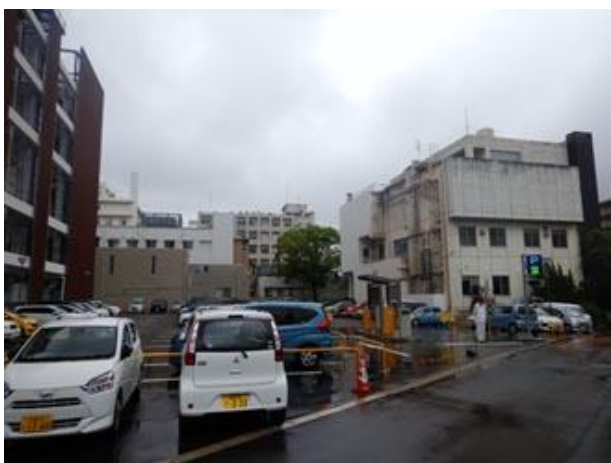
④左側に駐車場
